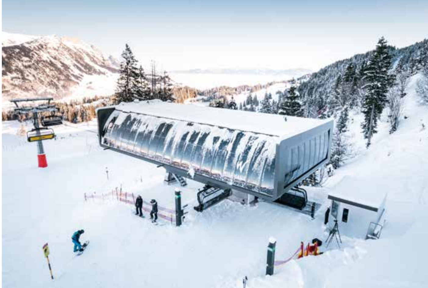
Das System überwacht die Anlage mit Kameras, Druckplatten, Sensoren und Lichtschranken. © Frey Stans
