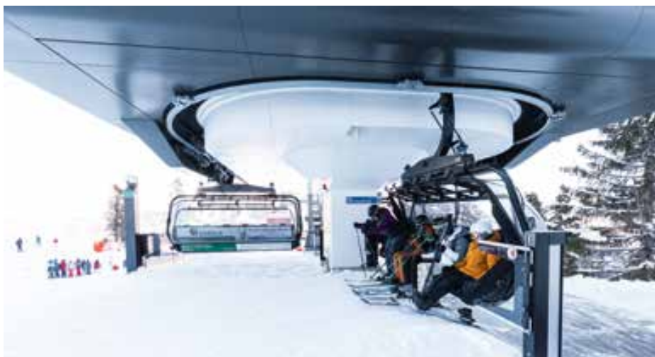
Die Wildhaus 6-CLD fährt mit der Connect Steuerung von FREY STANS, die mit AURO nachgerüstet wurde.
